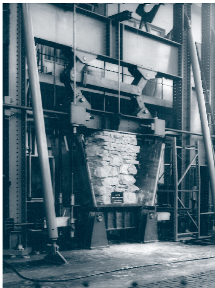
3. Preiskava kamnitega zidu po potresu na Kozjanskem leta [6] 4. Učinek injektiranja kamnitega zidu na Kozjanskem. Prirejeno po [6]
